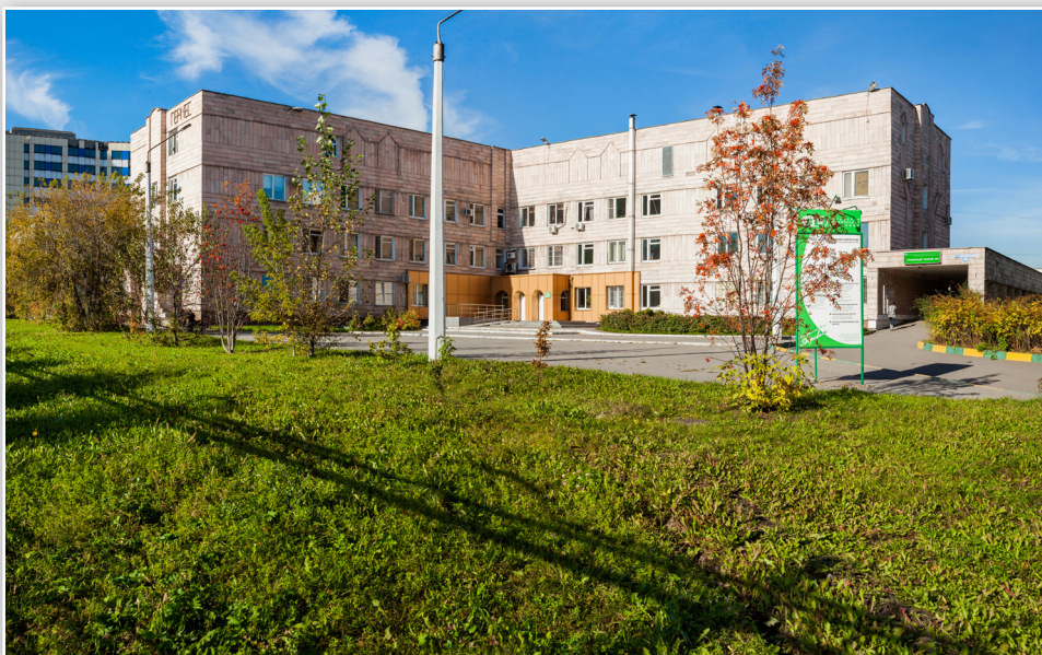
Здание хирургического корпуса №1
